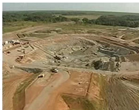
Pas de tir Soyouz en chantier : creusement du carneau de 28 m de profondeur pour évacuer les fumées lors du tir.
